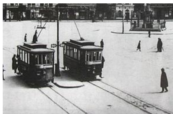
A pótkocsiból motorkocsivá átépített 6-os és 7-es villamos találkozik a Fő téri kitérőben.
